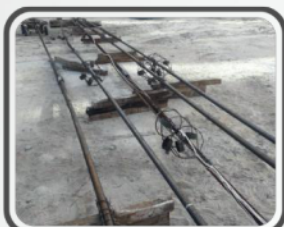
Instrumentação de estacas em profundidade
