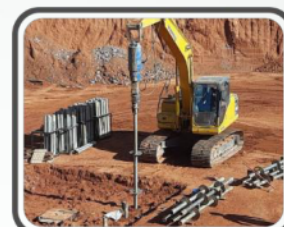
Ancoragem para provas de carga (SAP)
